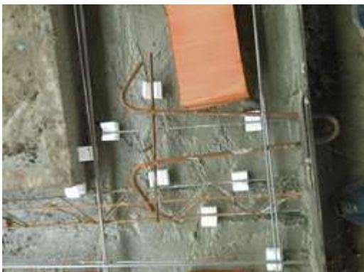
Figura 07 – Posicionamento das alças de içamento.
