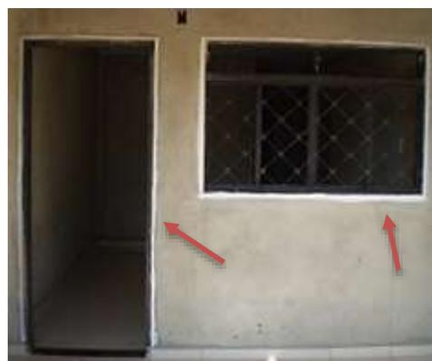
Figura 36 – Detalhe da emulsão acrílica no perímetro das esquadrias
