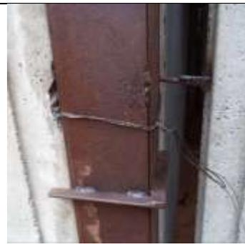
Figura 26 – Fôrma para grauteamento entre painéis.
