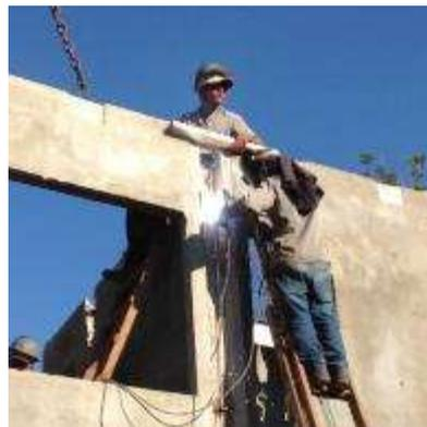
Figura 20 – Soldagem entre painéis.
