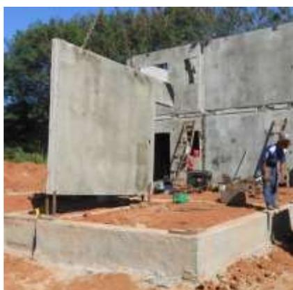
Figura 17 – Assentamento do painel de parede.
