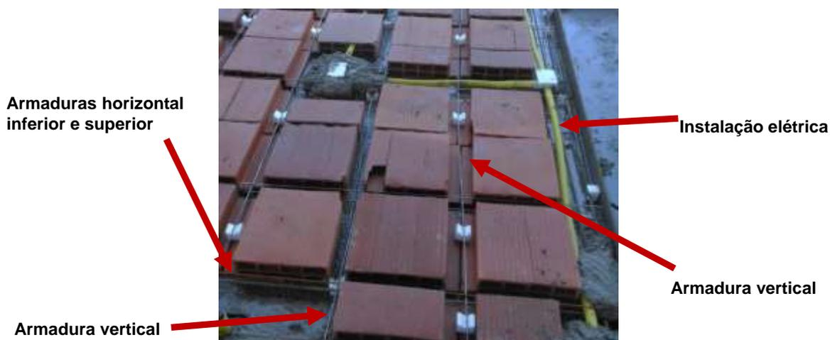
Figura 09 – Posicionamento das malhas superiores e inferiores das armaduras.
