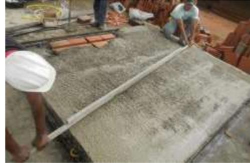
Figura 10 – Lançamento da segunda camada de concreto.
