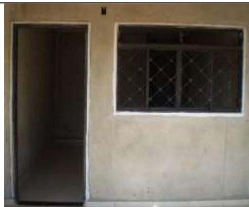
Figura 34 – Faixa de emulsão acrílica na interface da face externa do painel e perímetro das esquadrias.
