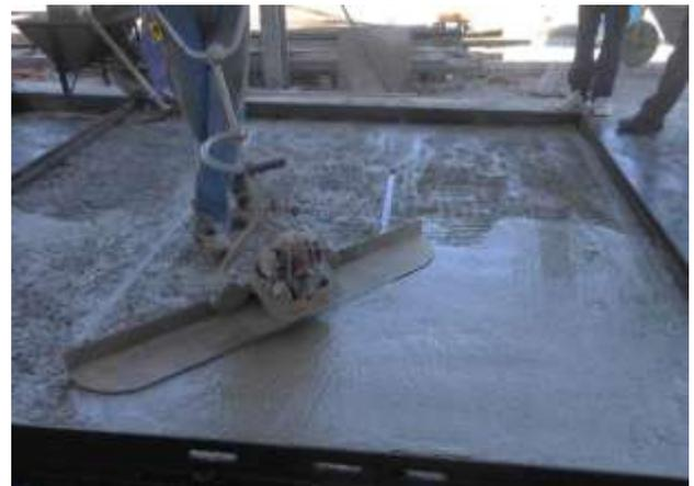
Figura 04 – Adensamento da primeira camada de concreto com régua vibratória.
