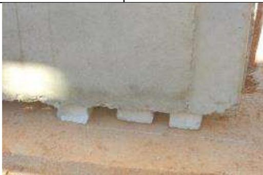
Figura 25 – Painel apoiado em calços de argamassa.
