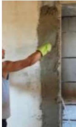
Figura 28 – Acabamento em camada de argamassa de revestimento.
