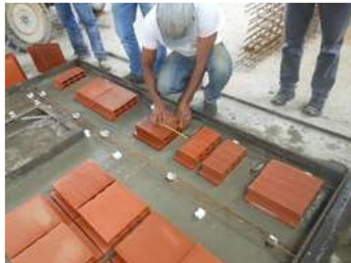
Figura 08 – Posicionamento das lajotas cerâmicas.
