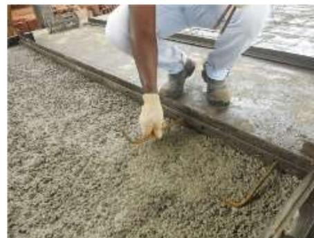
Figura 06 – Posicionamento das barras de soldagem.
