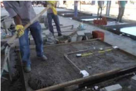
Figura 12 – Posicionamento das tubulações hidráulicas e lançamento da terceira camada de concreto ( $f_{ck}$  10MPa) em painel de parede hidráulica.
